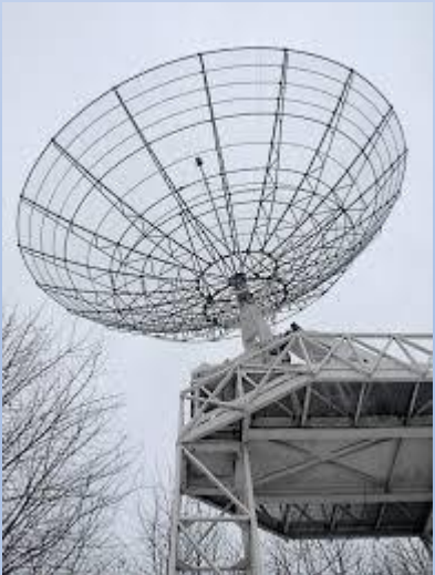
Radiotélescope La Villette ; diamètre 10 m ; gain 40 dB à 1296-1400 MHz
