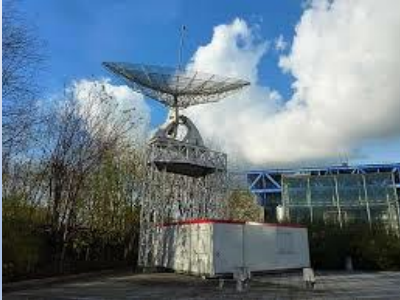
Radiotélescope La Villette ; diamètre 10 m ; gain 40 dB à 1296-1400 MHz
